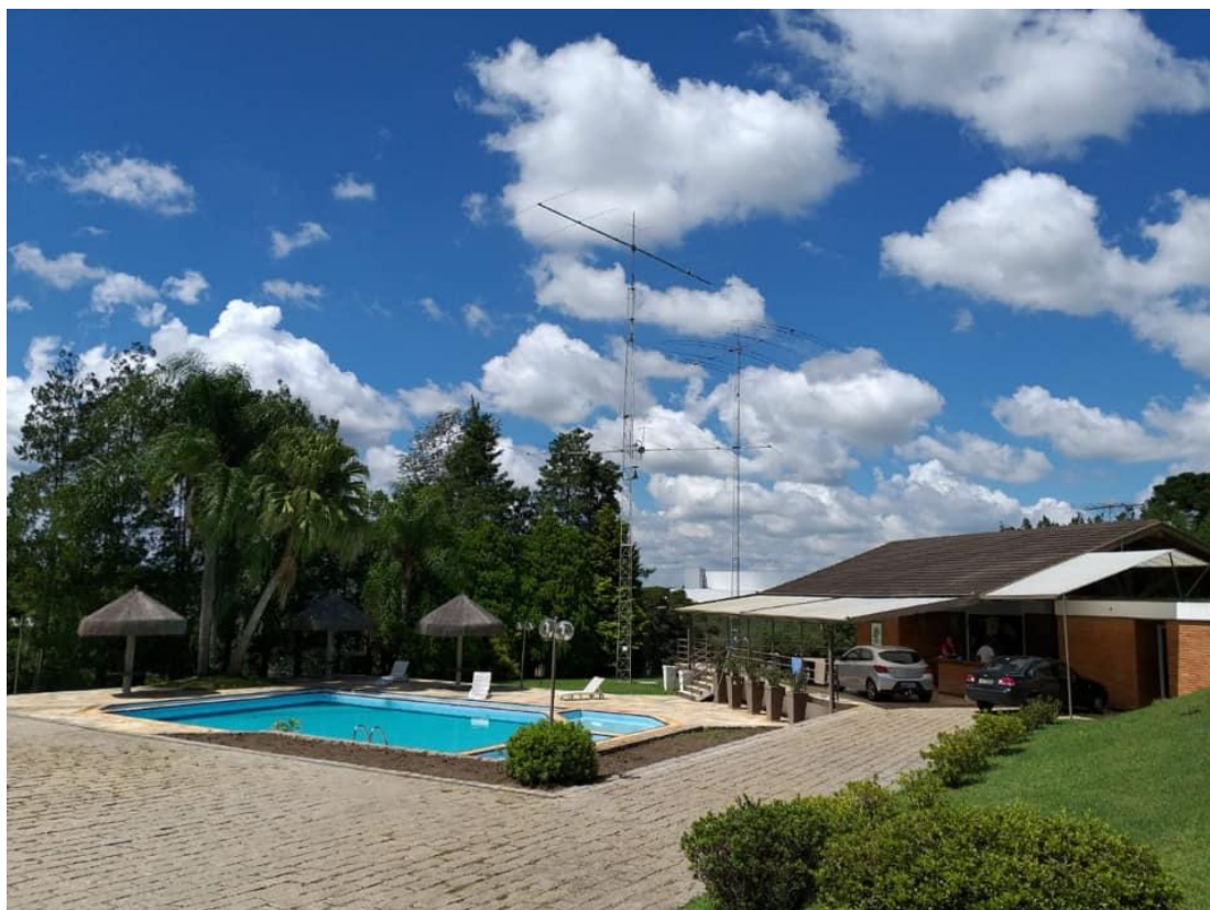
Imagem: podemos ver a torre com antenas de banda de 15 metros 8 sobre 8 empilhadas, Lança de 18 metros, com torre de 24 metros de altura. (projeto W2PV) e ao fundo à direita a antena Steppir
