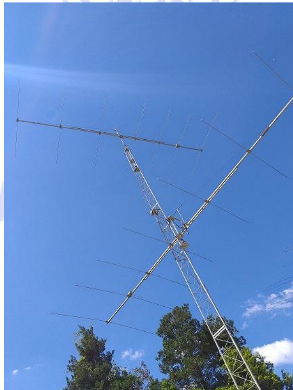
Imagem: Antenas de 10 metros 7 sobre 7 empilhadas, Torre de 30 metros de altura, auto-elevada
